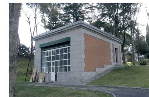
Réhabilitation de l'atelier n°1 dit Peñarroya.
