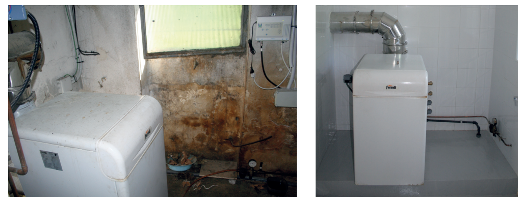
Mis aux normes de l'atelier n° 1 dit Peñarroya
