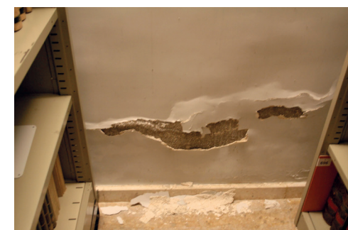
Réparation fuite sous-sol - zone bibliothèque
