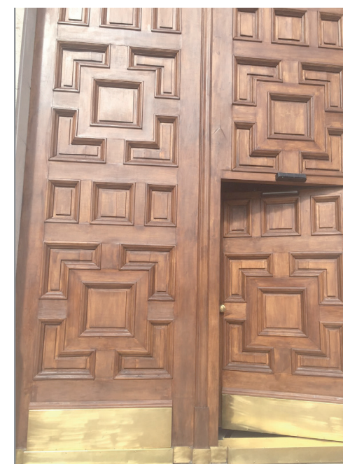
Restauration de la porte d'entrée monumentale
