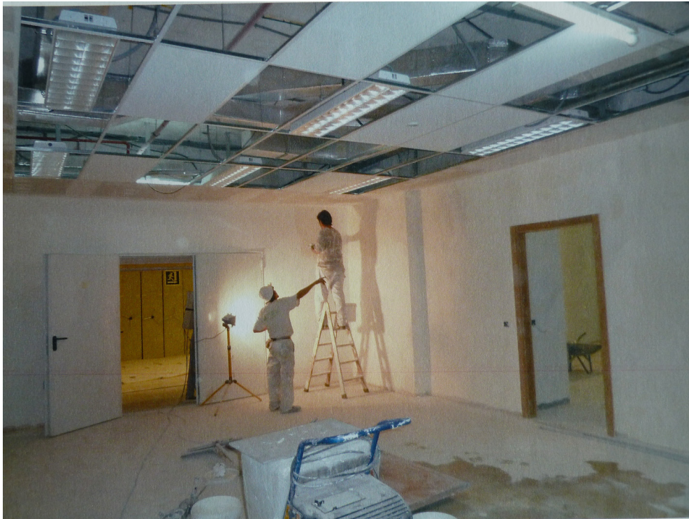
Salle de consultation au sous-sol de la bibliothèque
