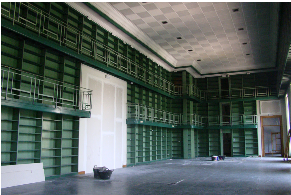
Novembre 2009 : le déménagement est terminé. Place au travaux !
