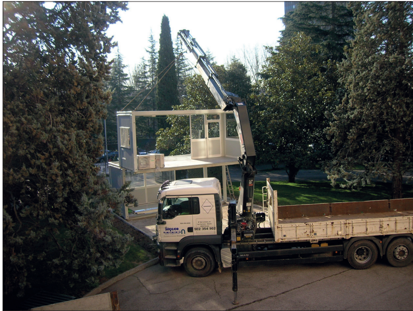
Installation de l'Algeco pour la conciergerie devant le bâtiment central
